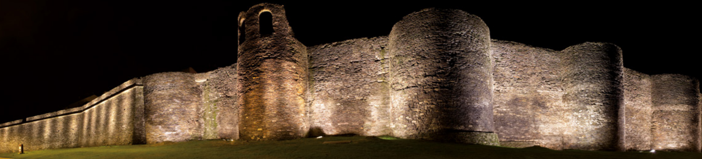
RÖMISCHE STADTMAUER IN LUGO
