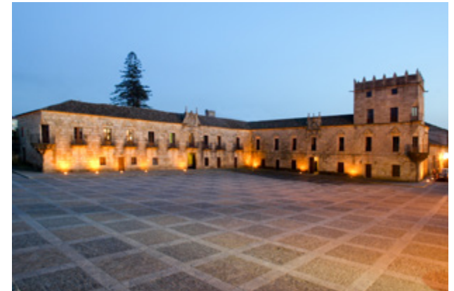
PLAZA DE FEFIÑÁNS, CAMBADOS
