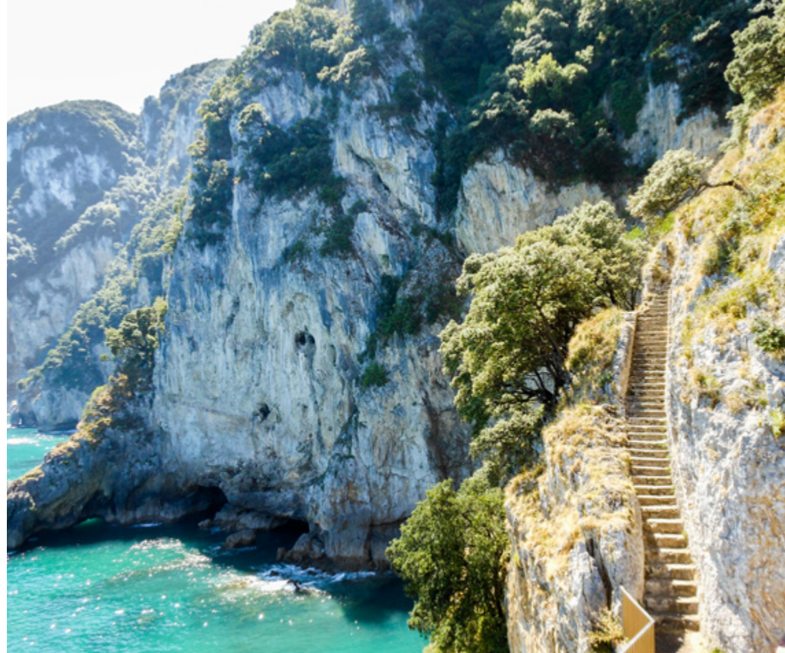
AS ESCADAS QUE CONDUZEM AO FARO DEL CABALLO, EM SANTOÑA
